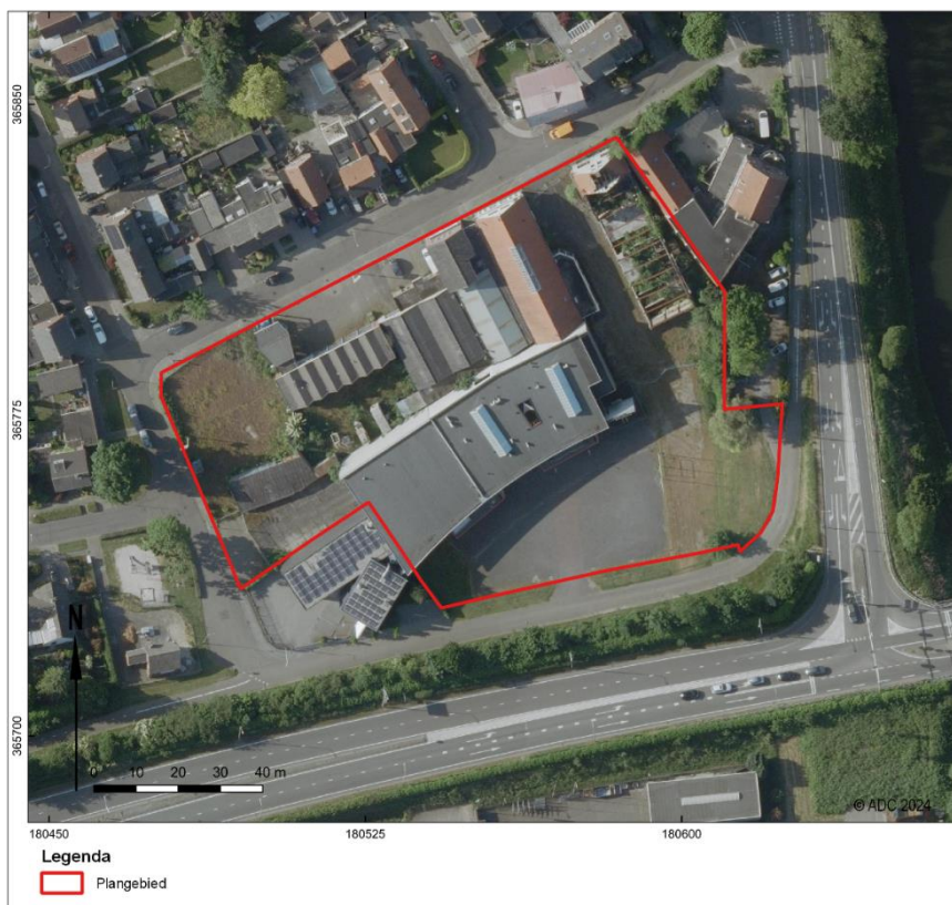
Afb. 4. De luchtfoto van het plangebied
