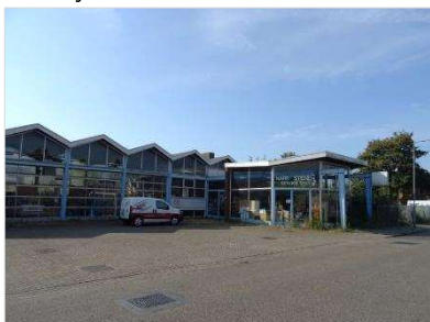
Figuur 2.6. Autogarage aan noordzijde onderzoekslocatie.
