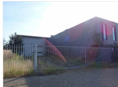
Figuur 2.8 Pand Fysio Fitness tegen onderzoekslocatie aan gebouwd.
