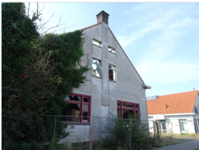
Figuur 2.3 Uitgebrand bedrijfspand aan noordzijde onderzoekslocatie.
