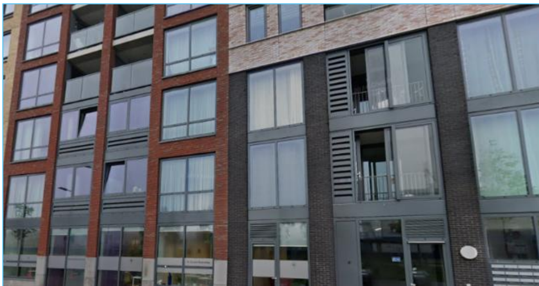
Figuur 7.8: Bouwkundige maatregel: geluiddempend ventilatierooster
