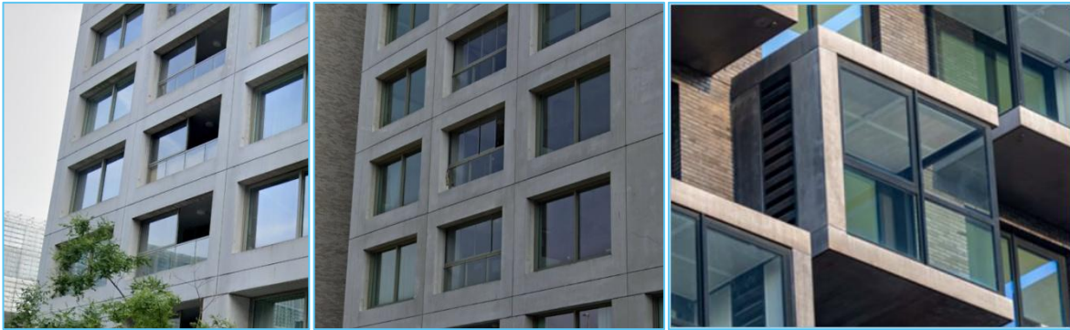
Figuur 7.6: Bouwkundige maatregel: (deels) verglaasde loggia
