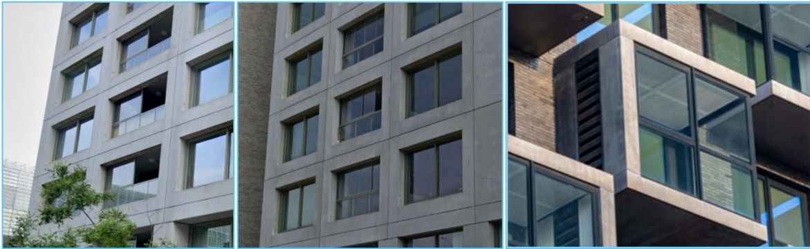
Figuur 7.6: Bouwkundige maatregel: (deels) verglaasde loggia
