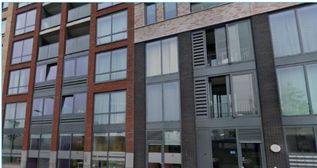
Figuur 7.8: Bouwkundige maatregel: geluiddempend ventilatierooster
