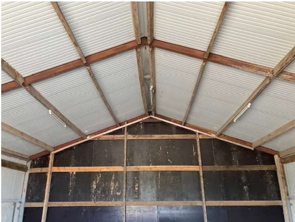
• Afbeelding 10: Overgebleven stallen, bestaan uit sandwich panelen
