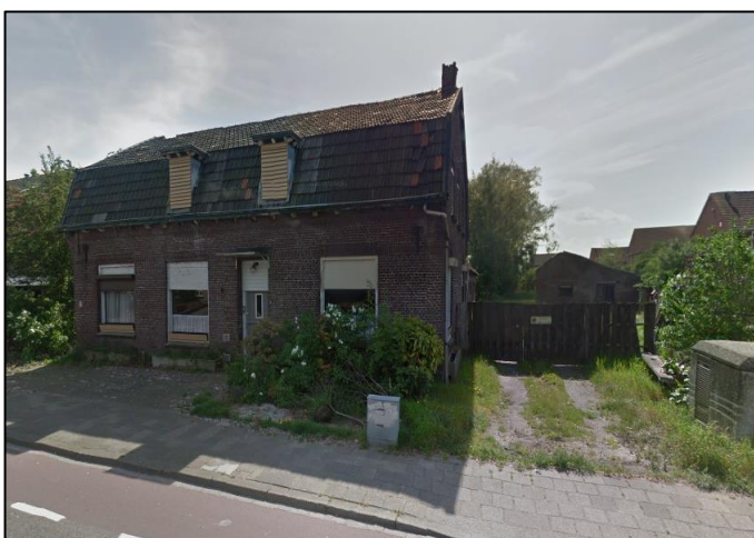
Foto's bestaande situatie
