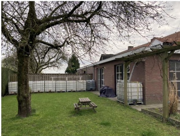
Foto 13 IBC's ten behoeve van opvang van regenwater
