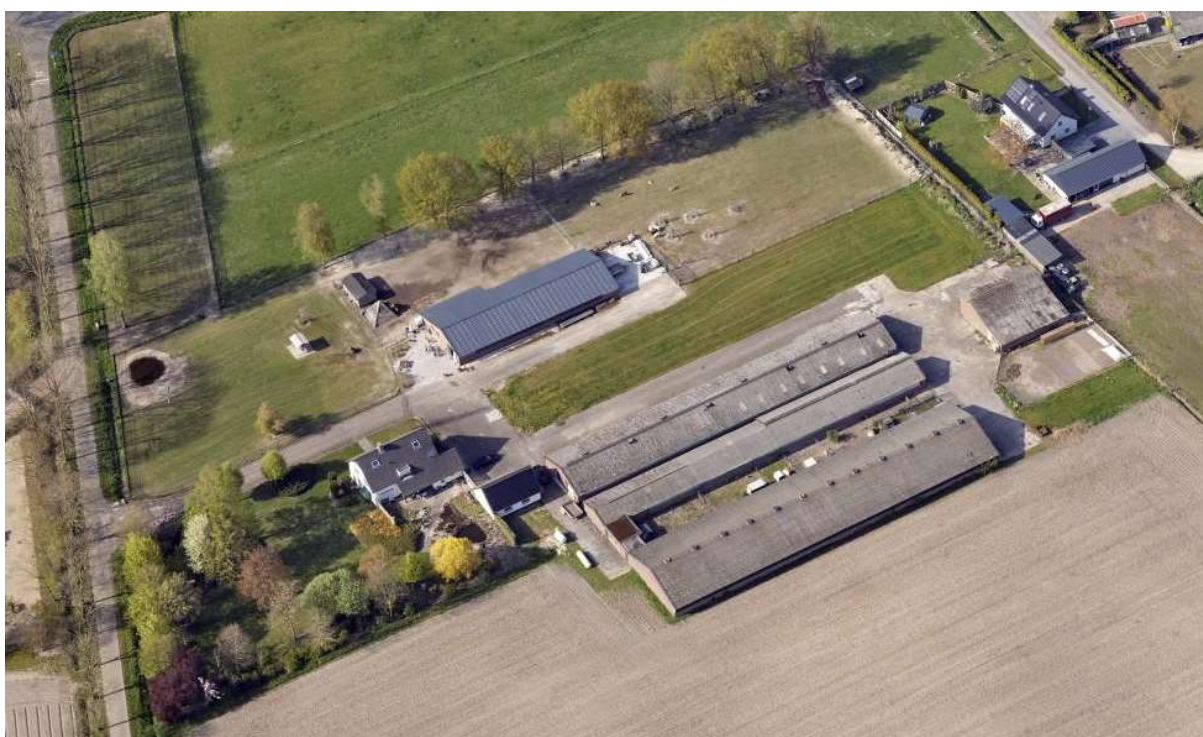
figuur 4: Visdijk 3 (bron: obliek)
