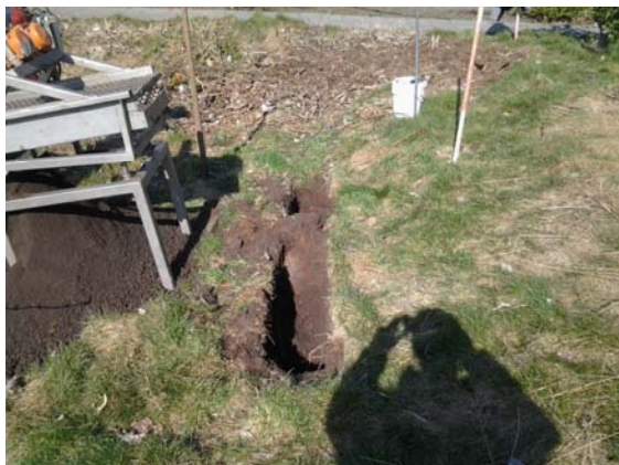
Asbestsleuf S2 nabij boring 6 / gat G6
