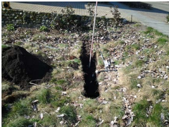
Asbestsleuf S1 nabij boring 5 / gat G5
