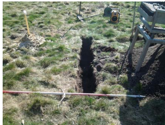
Asbestsleuf S3 nabij peilbuis P1 / gat G1
