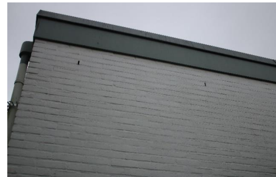
Figuur 3.3: Open stootvoegen, boeideel en daktrim van gebouw 1.
