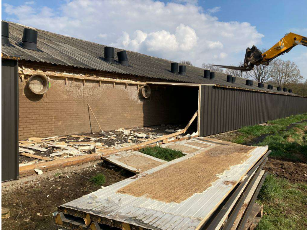
• Afbeelding 3: te slopen stal
