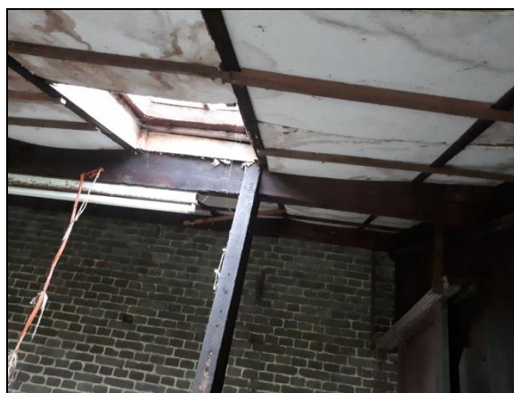
Figuur 10. Ruimte onder dakbeschot geschikt voor vleermuizen
