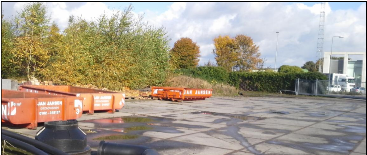
Noordzijde terrein, wal en opslagterrein
