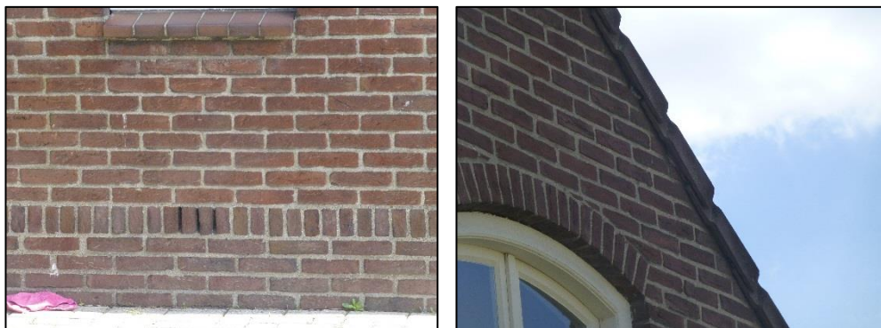
Figuur 4.3. Indicatie aanwezige spouwmuur en (rechts) kantpannen die mogelijk toegang kunnen geven tot potentiële geschikte vleermuisverblijfplaatsen.
