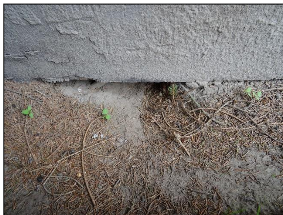
Figuur 2. Gegraven opening onder schuur.
