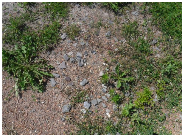
Foto 24 Gebroken puin als verhardingsmateriaal
