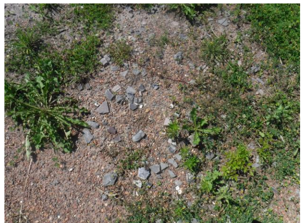
Foto 24 Gebroken puin als verhardingsmateriaal
