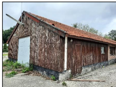
Figuur 4. Deel voormalige autosloperij, kijkrichting zuidoosten.
