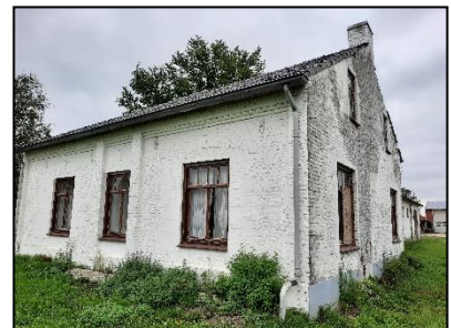
Figuur 5. Voormalige woonboerderij, kijkrichting oosten.
