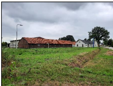
Figuur 3. Bebouwing en drooggevallen greppel op onderzoekslocatie, kijkrichting zuidoosten.
