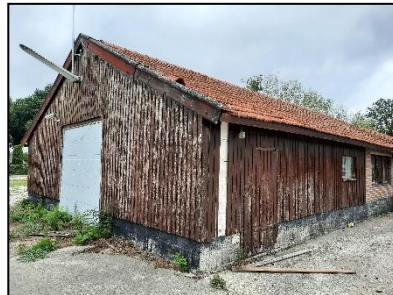
Figuur 4. Deel voormalige autosloperij, kijkrichting zuidoosten.
