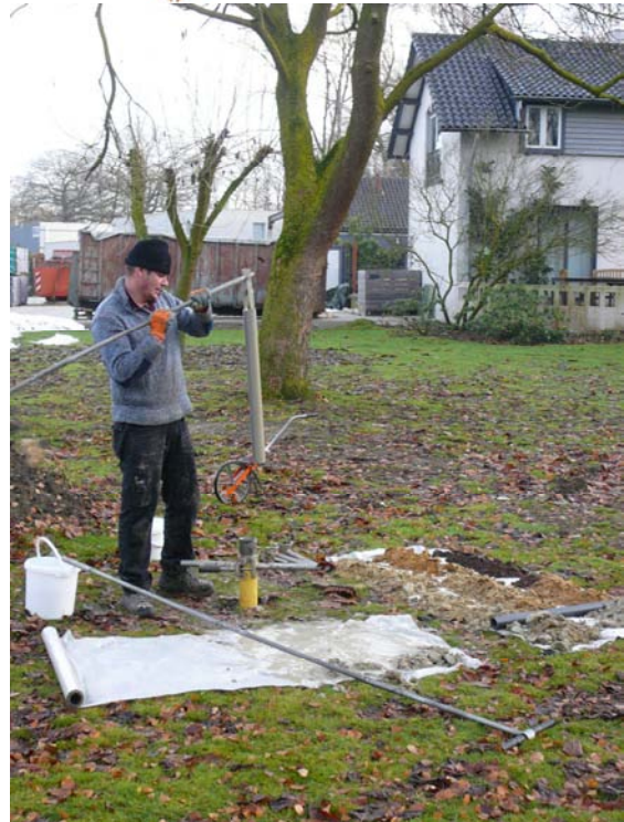
Situatie boring/peilbuis P1
