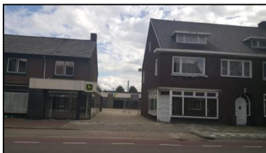
Figuur 3. Voorzijde onderzoekslocatie aan de O.L. Vrouwestraat.
