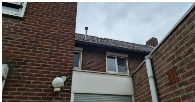
Figuur 8: Zuidgevel van het gebouw, gezien vanuit het zuiden
