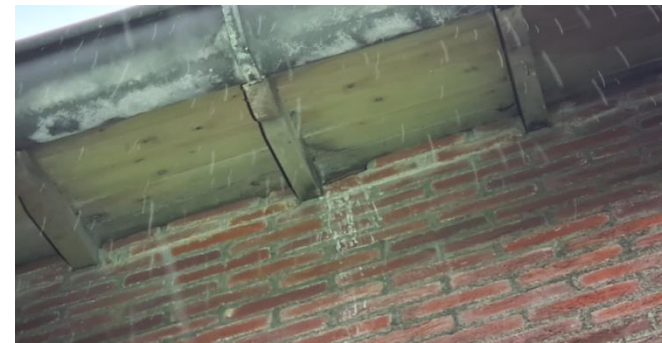
Figuur 11: Mogelijk gierzwaluwnest achter kier tussen dakoverstek en gevel, in de noordzijde van het gebouw
