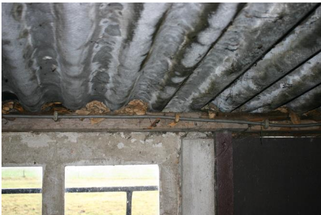
Figuur 5. De schuur is belegd met golfplaten.
