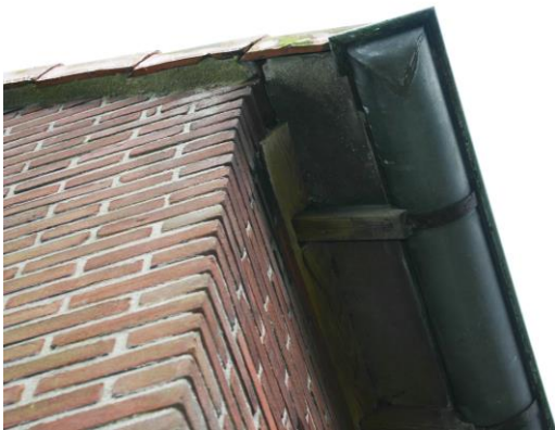
Figuur 4. De gevelpannen zijn met specie afgewerkt.
