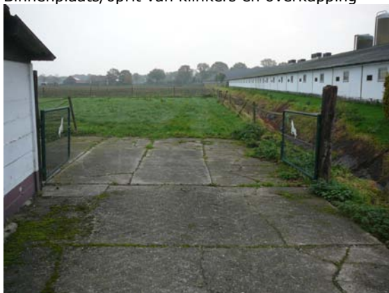
Zicht oprit beton in oostelijke richting
