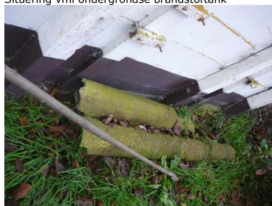
2 asbestbuizen noordelijke kopse zijde schuur
