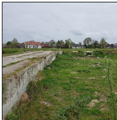
Figuur 8. Betonfundering in het middengedeelte van de locatie.
