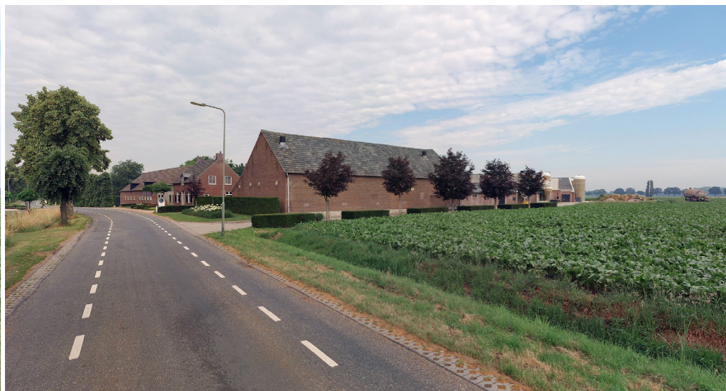
Aanzicht voorzijde erf en oude langgevelboerderij - Cyclomedia
