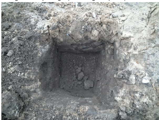
Foto 15 Boring 104 + inspectiegat (voormalige drupzone)
