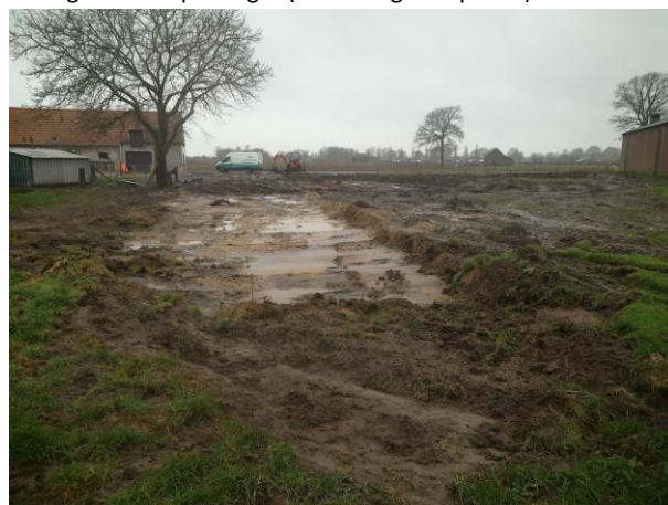
Foto 16 Locatie voormalige bedrijfsgebouwen na de sloop
