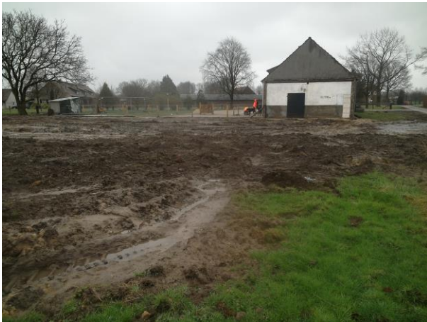
Foto 19 Aanzicht noordzijde woonhuis alwaar de aanbouw gesloopt is
