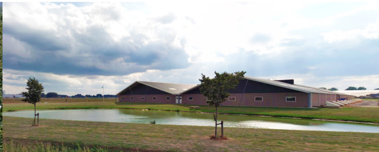
Infiltratievijver met gemaaid grasveld
