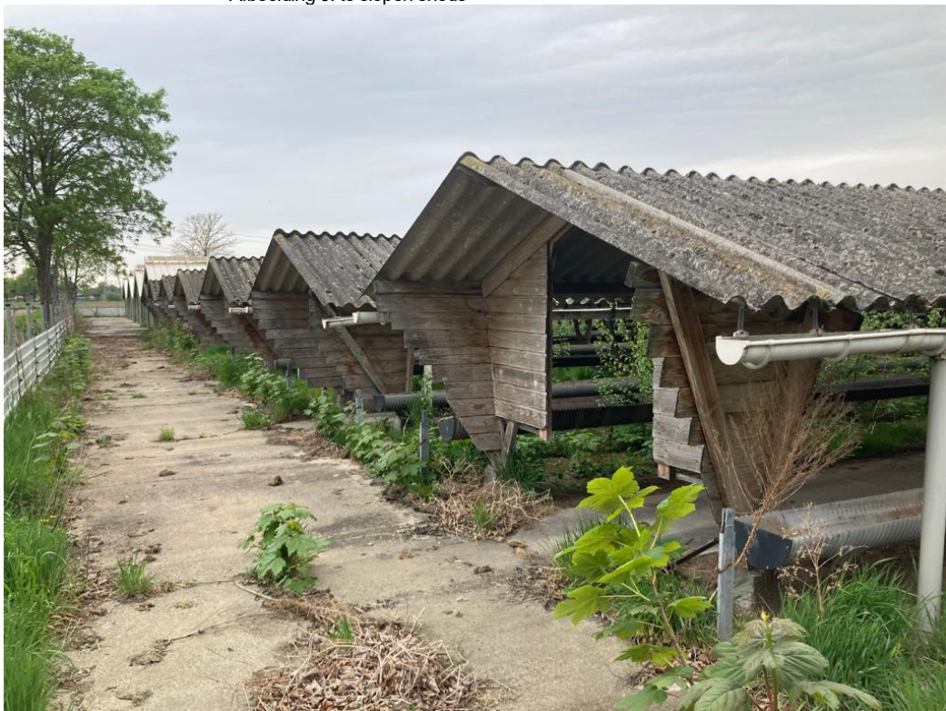
• Afbeelding 9: te slopen sheds
