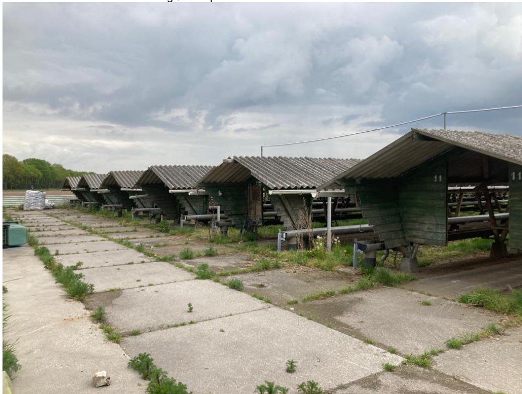
• Afbeelding 3: te slopen sheds
