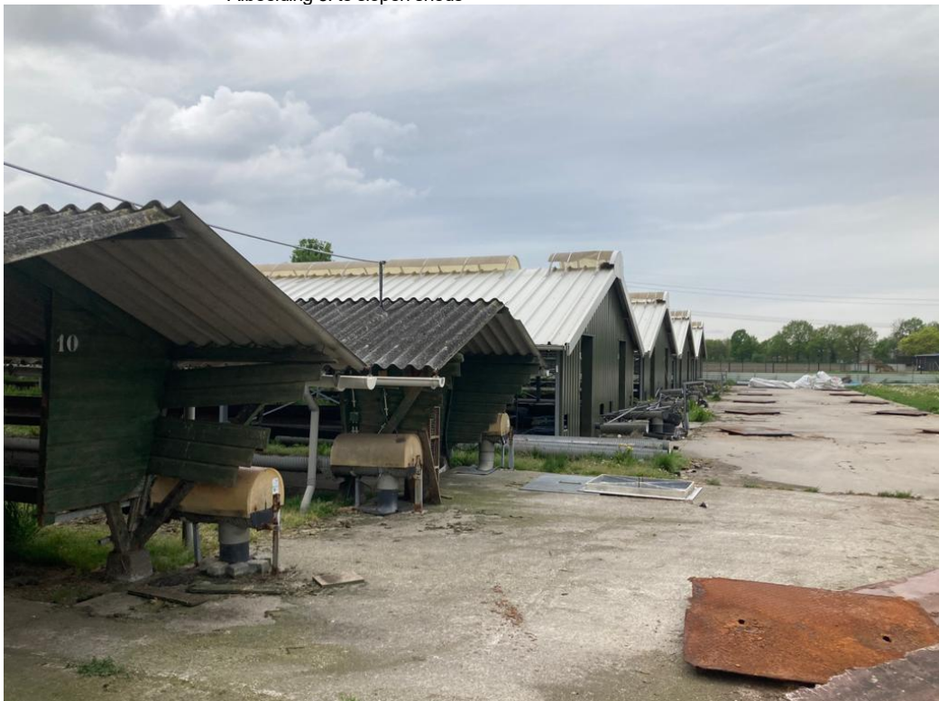
• Afbeelding 5: te slopen sheds
