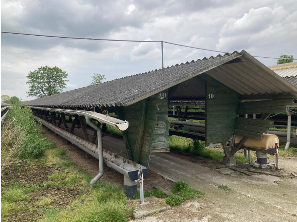
• Afbeelding 4: te slopen sheds
