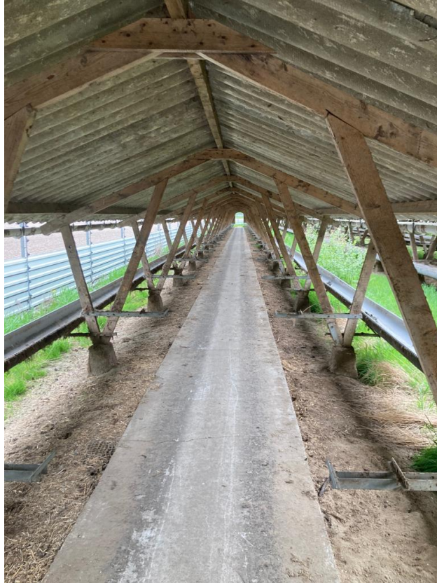
• Afbeelding 8: te slopen sheds
