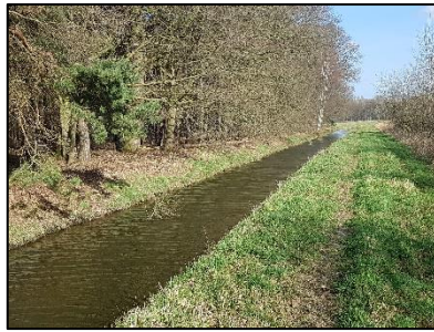
Figuur 10. Rosveldlossing aan noordwestzijde van de onderzoekslocatie.
