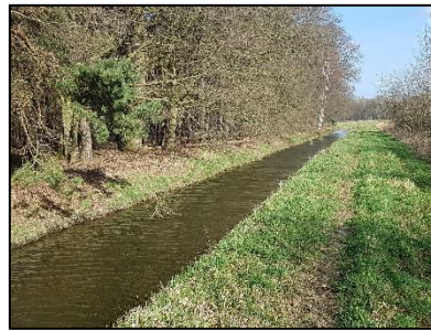
Figuur 10. Rosveldlossing aan noordwestzijde van de onderzoekslocatie.
