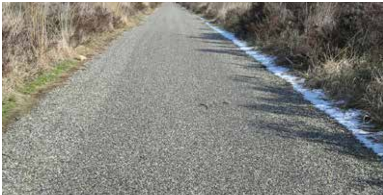
Asfalt met afstooilaag
