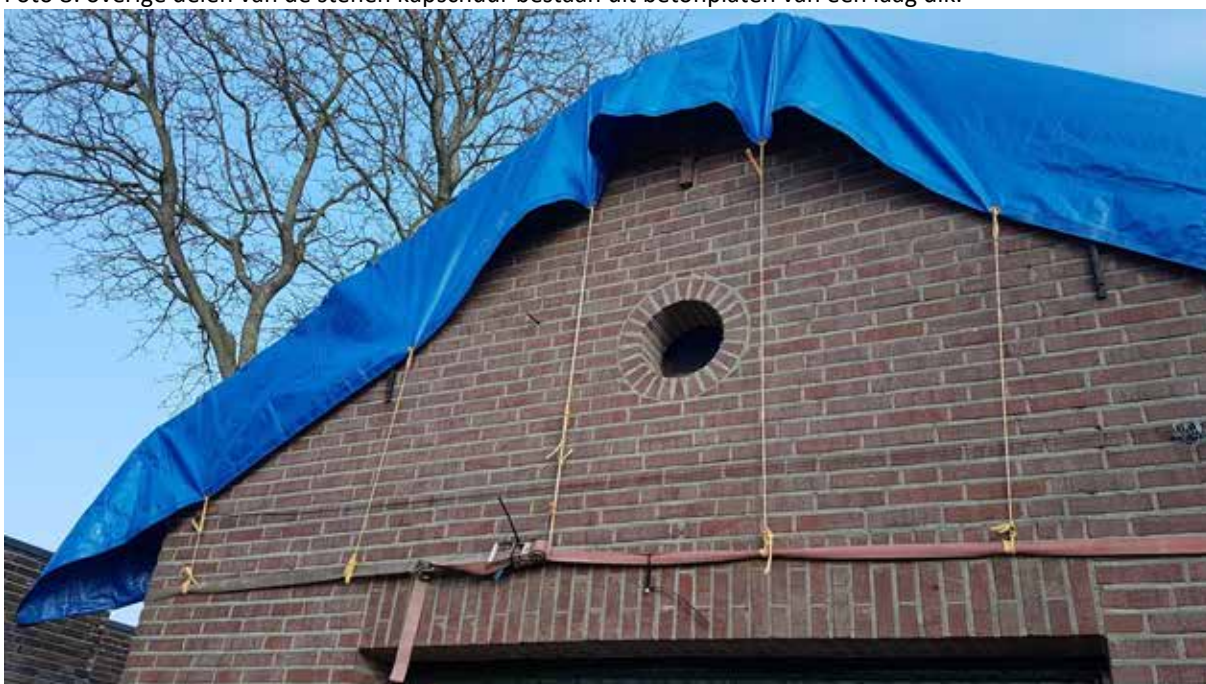
Foto 9: de voorgevel van de steden schuur. In de muur zitten geen hoge stootvoegen. Het uilengat is van binnenuit gedicht
