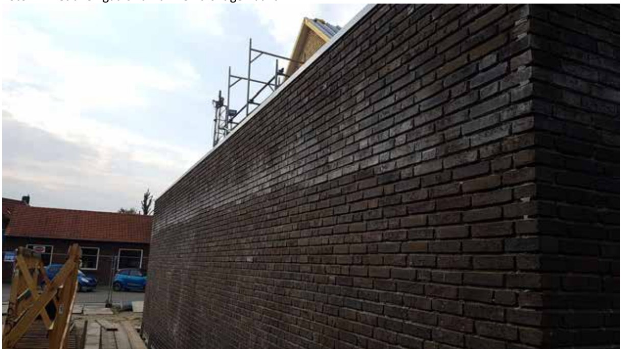
Foto 13: de toekomstig gedeelde muur van het al gerealiseerde woonhuis.
