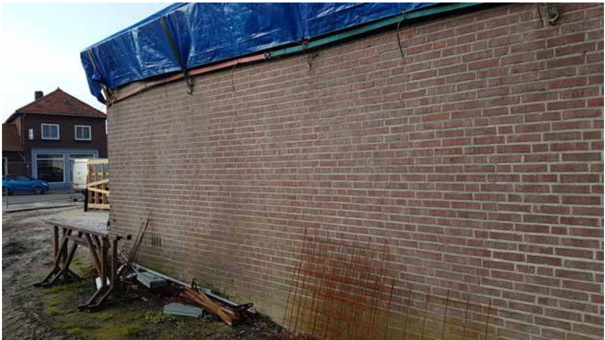
Foto 11: de spouw heeft alleen openstootvoegen laag bij de grond.
