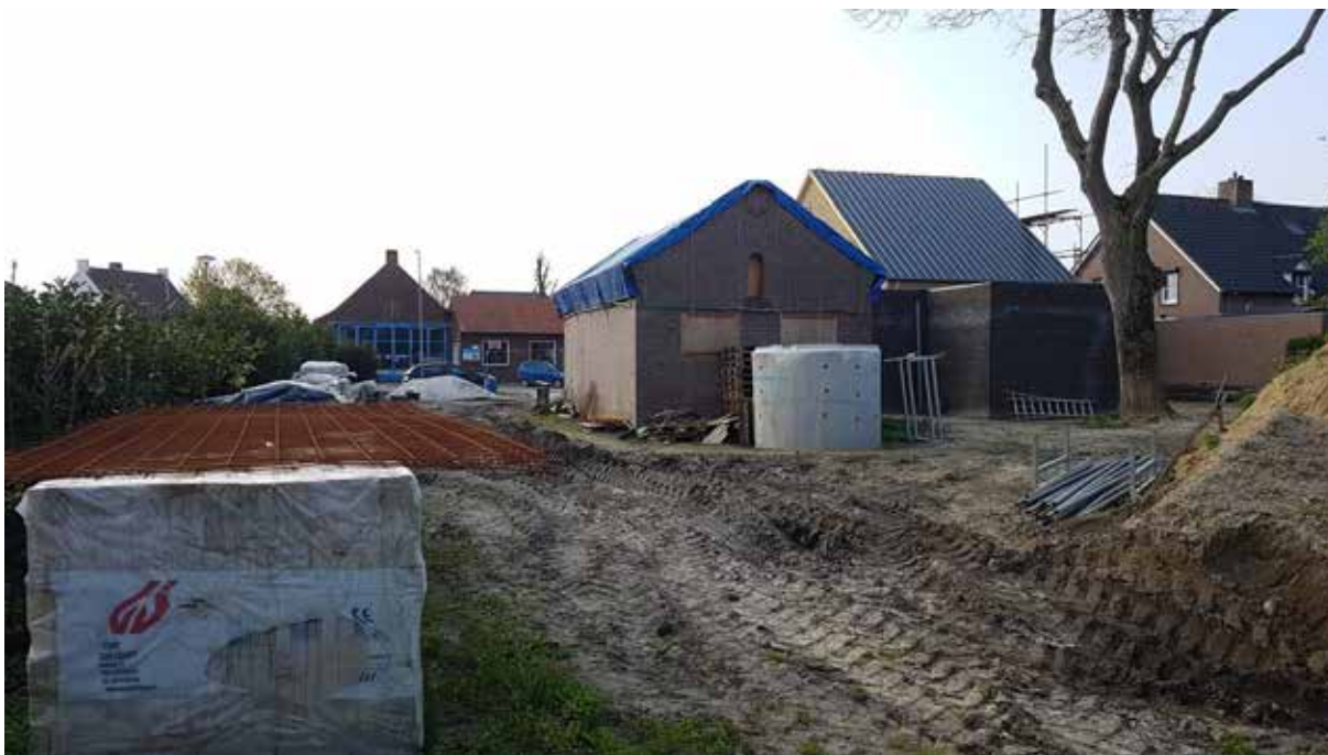
Foto 1: De grote stenen schuur. Kijk richting is zuidelijk. Rechts van de schuur het reeds gebouwde woonhuis en de grote notenboom.
