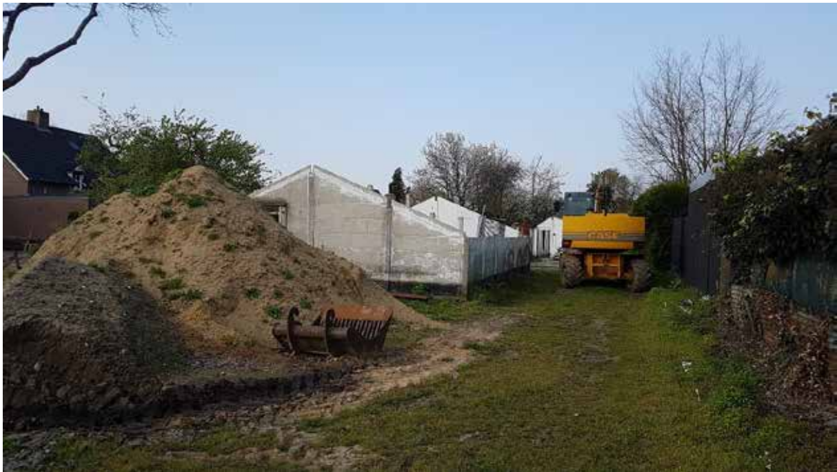
Foto 6: de twee stenen kapschuren hebben geen dak meer. In de voorgrond de zandstapel.
