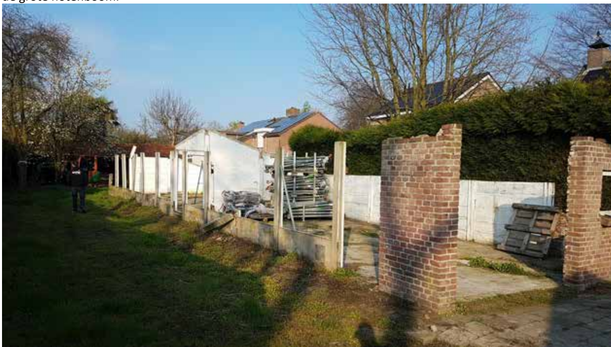
Foto 2: een van de twee stenen kapschuren bestaande uit betondelen en gemetselde delen. Links de twee fruitbomen met erachter de houten kapschuur.
