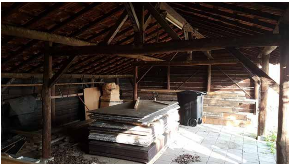
Foto 3: de houtenkapschuur heeft geen dakbeschot en de wanden zijn gepotdekseld. Hier liggen wat bouwmaterialen opgeslagen.
