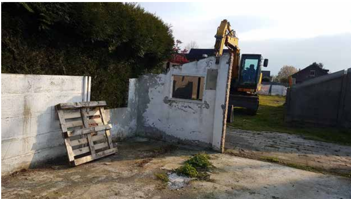
Foto 8: overige delen van de steden kapschuur bestaan uit betonplaten van een laag dik.
