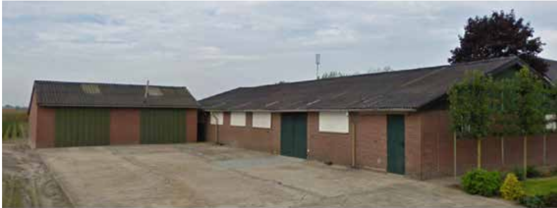
Overzicht van de te slopen bebouwing (links de garage, rechts de kippenschuur).
