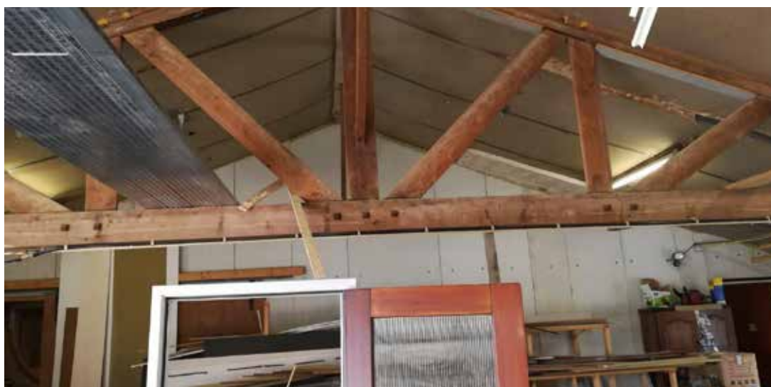
Binnenzijde kippenschuur, momenteel gebruikt als werkplaats
