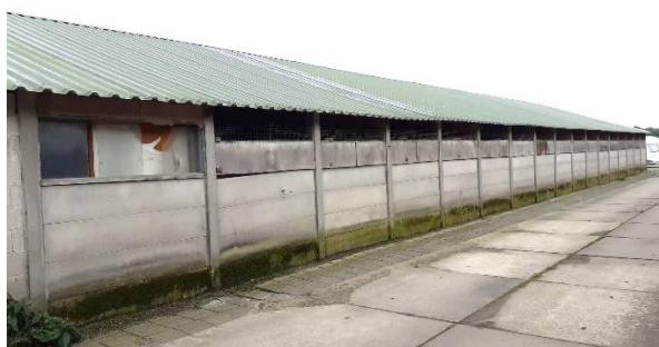
Gebouw 2 zijgevel met enkelsteens betonplaten/blokken. Dak van ongeïsoleerde damwand
