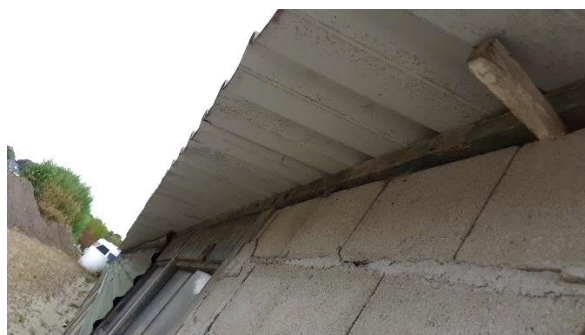
Gebouw 2 zijgevel met enkelsteens betonplaten/blokken. Dak van ongeïsoleerde damwand
