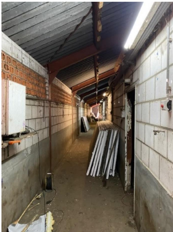
Loopgang intern (isolatie reeds verwijderd)
