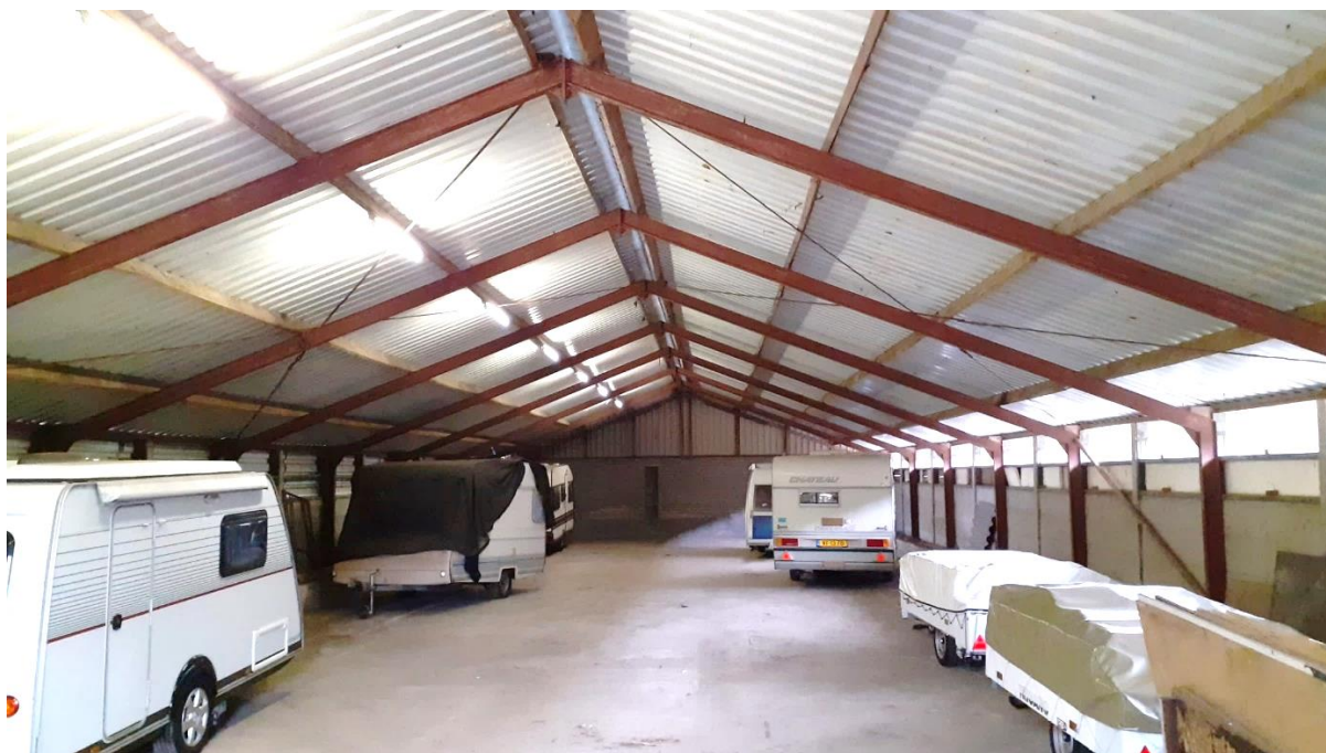
Binnenzijde gebouw 2, zijgevels zonder spouw met enkelsteens betonplaten/blokken. Dak van ongeïsoleerde damwand
