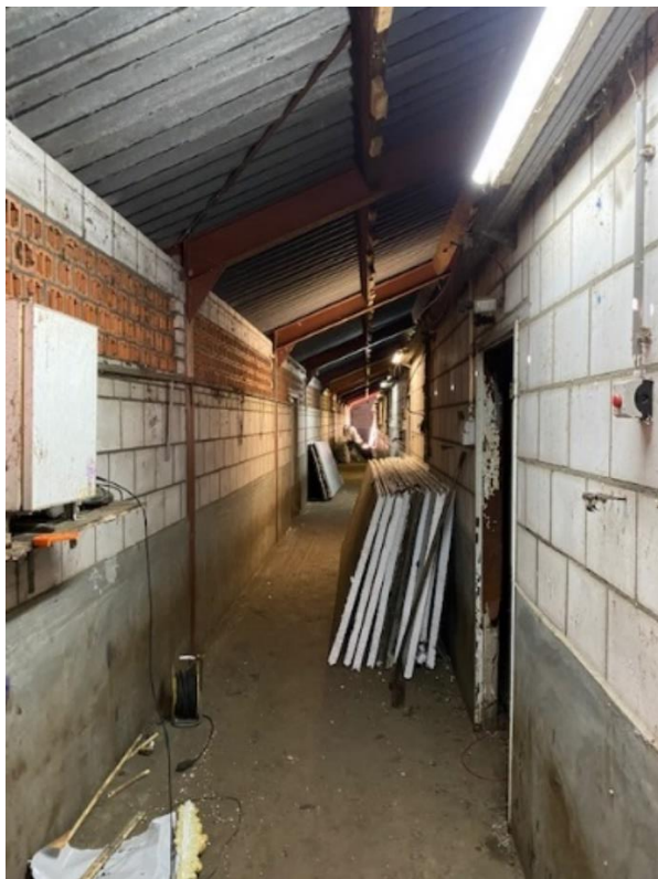
Loopgang intern (isolatie reeds verwijderd)
