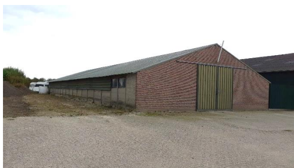
Gebouw 2 voor en zijgevel
