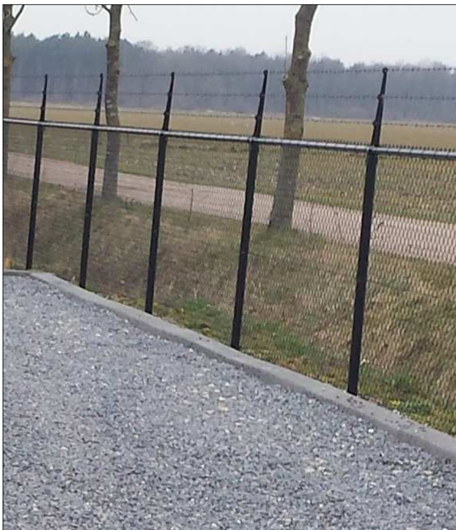
Figuur 8: terreinverharding en opstaande betonrand kant Grasdijk
