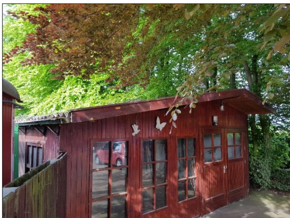
Figuur 6. Timmerschuur zuidoosten plangebied
