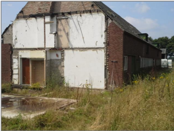
Foto 13: gesloopte woning zuidelijk deel van de boerderij
