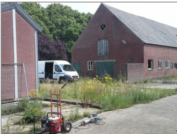
Foto 3: was/spoelplaats met links de werktuigenloods en aan de achterzijde de boerderij
