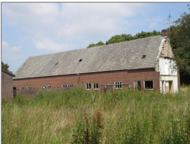
Foto 15: boerderij met rechts de gesloopte woning
