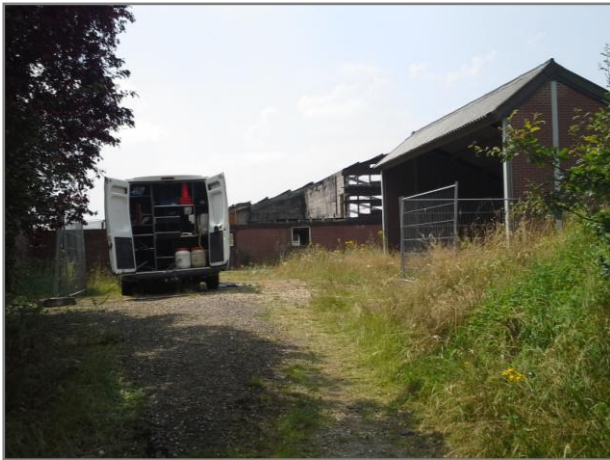
Foto 1: inrit vanaf Lambertusweg met rechts werktuigenloods en ligboxenstal
