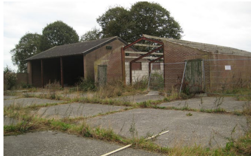
Beton en asfaltverharding
