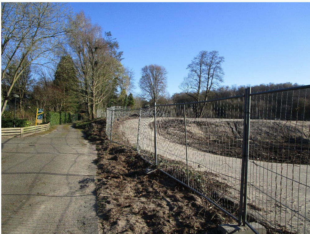
Grens plangebied aan westzijde langs de Rijksweg (kijkend in noordelijke richting)
