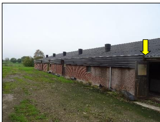
Figuur 10. Oude varkensstal, nummer 4, met geschikte ruimtes onder de dakbedekking voor huismussen.
