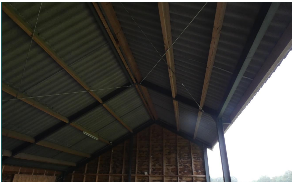
Figuur 2 Het dak van de schuur bestaat uit golfplaten die rusten op stalen en houten planken.
