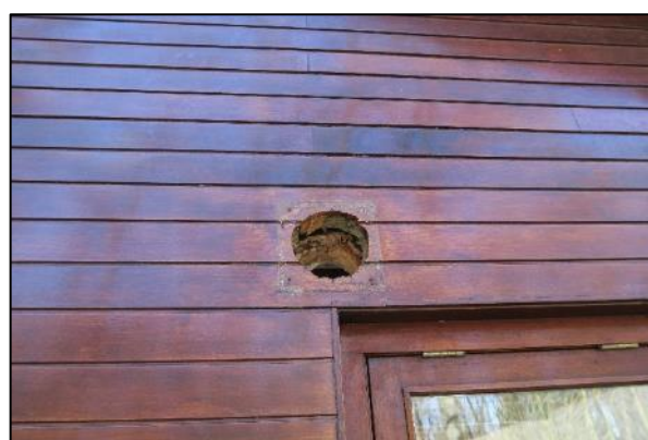
Foto 4. Opening in de muur aan de noordwestzijde van de woning
