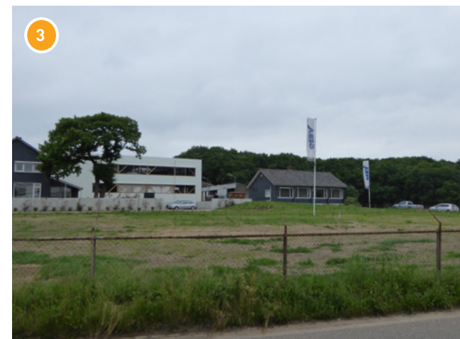
Zicht op de locatie vanaf de Bovensteweg. De nieuwe bedrijfshal is in aanbouw. De bedrijfshal is inmiddels gerealiseerd. De gevel is bekleed met platen die groen en donkerrood meekleuren met de bomen erachter.
