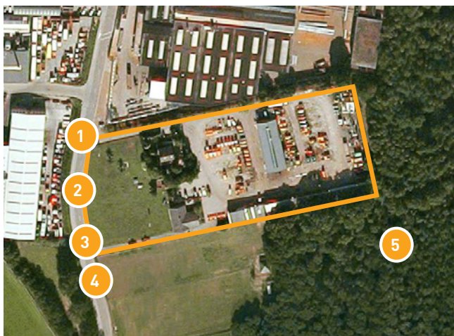
Luchtfoto Bovensteweg 48 (situatie voor bouw bedrijfshal en parkeerplaats)
