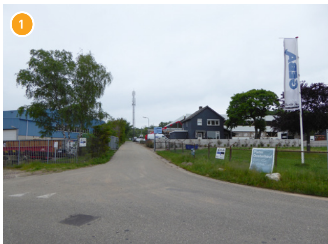
De huidige ontsluitingsweg, aan de noordzijde van het perceel, wordt nu gebruikt als in- en uitrit voor werkverkeer.
