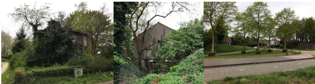
Situatie in het plangebied voor de sloop van de woning (bron: initiatiefnemer)
