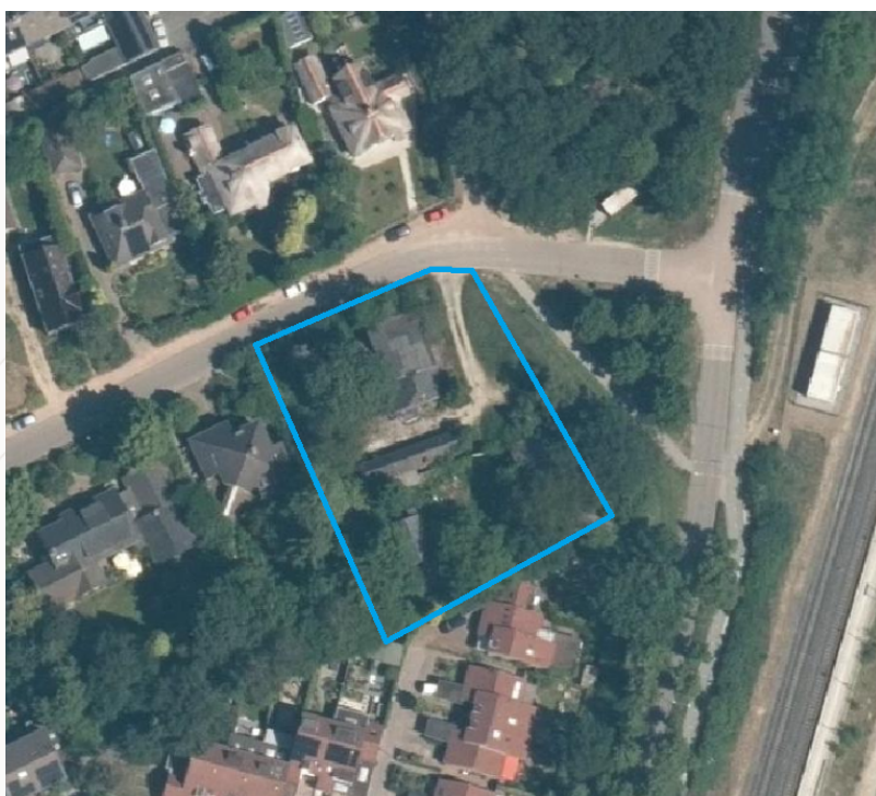
Luchtfoto bestaande situatie voor de sloop van de woning plangebied (bron: Ruimtelijkeplannen.nl)
