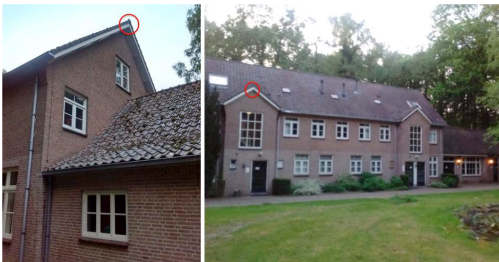
Figuur 4.1 Zomerverblijfplaatsen en uitvlieglocaties gewone dwergvleermuis (rood omcirkeld) in het meest oostelijk gelegen gebouw.
