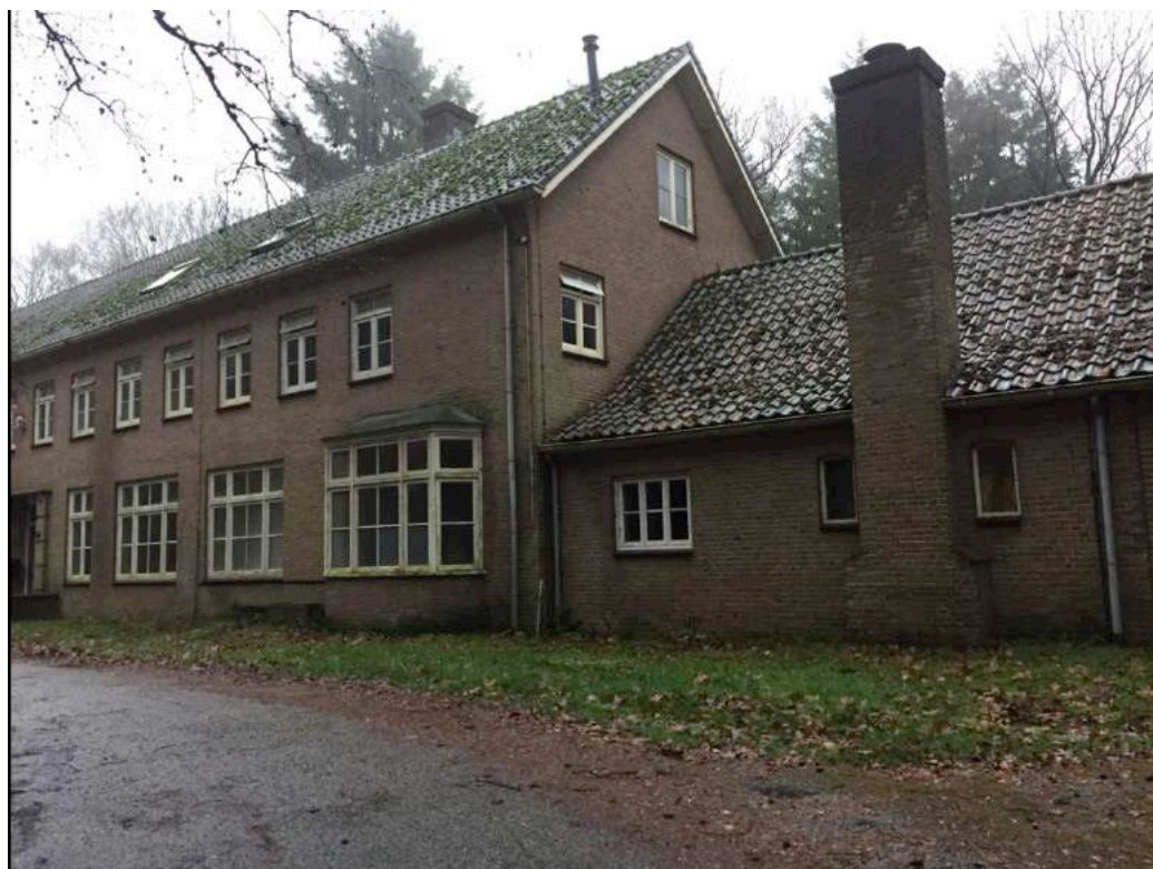
foto 2.2 Een van de momenteel leegstaande gebouwen. Deze gebouwen worden gesloopt.
