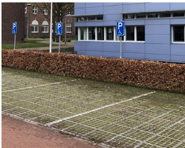
Parkeren op waterdoorlatende verharding
